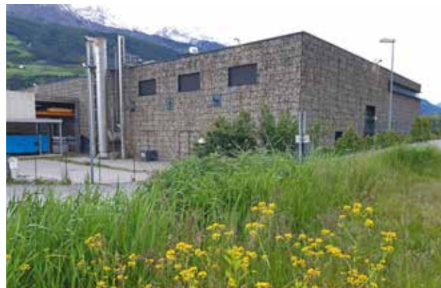
Pflanzen hatten am Dach des Fernheizwerkes die PV-Anlage gestört, sie wurden entfernt
