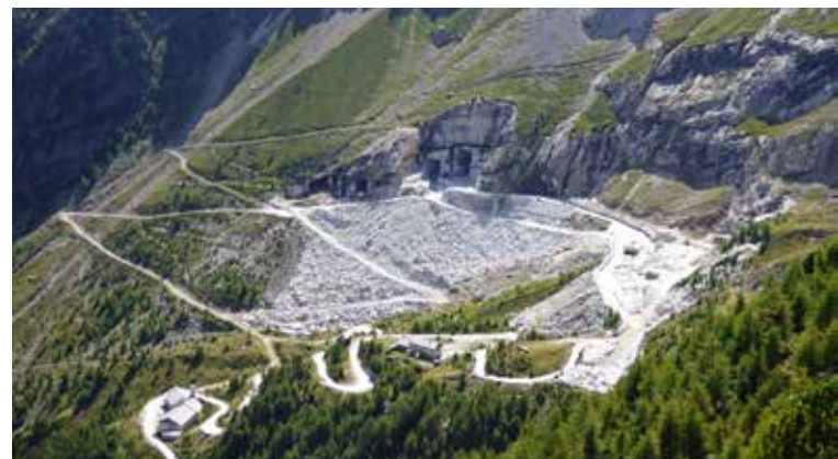
Die Marmorstraße mit Kantin (unten) und dem Maschinenhaus
