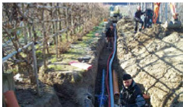
Austausch eines Teilstückes der Trinkwasser- und Abwasserleitung Zone Grübl - Zerminger-Viertel, Herbst 2013
